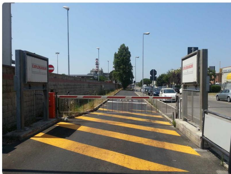
Figura 3.1 – Esempio di portale per la sorveglianza radiometrica dei carichi in ingresso.
